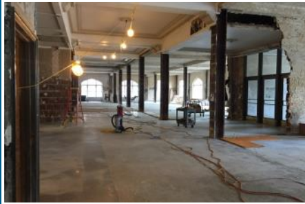
Edificio de Registros Después de Demolición
