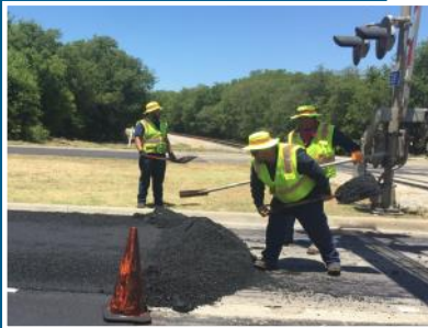
Equipo de Caminos y Puentes 4 trabajando con asfalto
