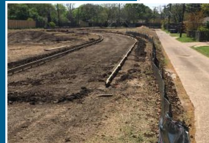
Parte del Sendero Northaven bajo construcción
